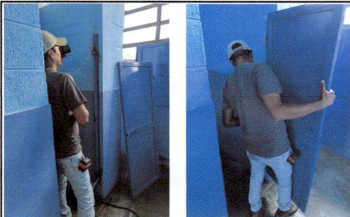
Foto 1: Instalando marco y la puerta del sanitario.
