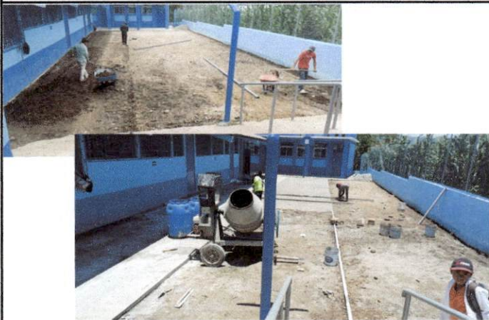
Foto 3: Retiro de losa anterior, nivelación de suelo e instalación de nueva losa para el patio deportivo.
