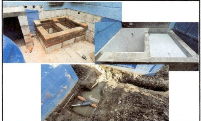
Foto 2: Construcción de un polletón de 2 parrillas. Reparación de pila e instalación del sistema de drenaje de la pila al exterior.
