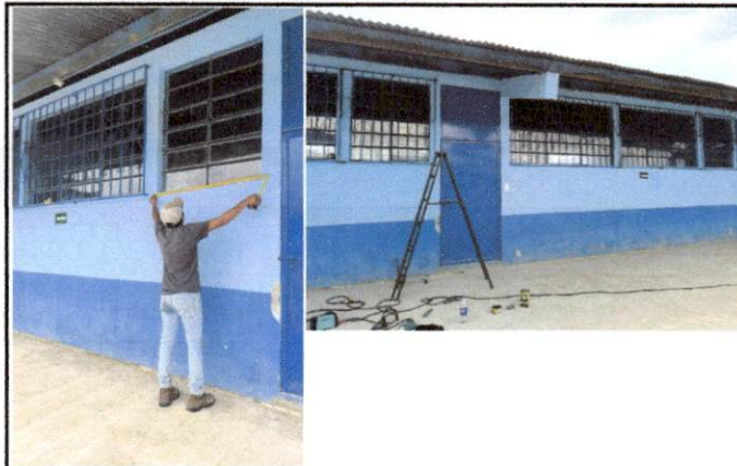
Foto 2: Tomando medidas para fabricar los 3 balcones a instalar.
