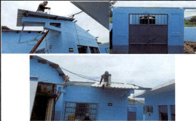
Foto 1: Instalación de costaneras y láminas del lavadero y de la cocina. Reparación del techo de lámina en módulos de aulas.
